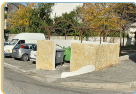
Remise en état des logettes - La Poncette
