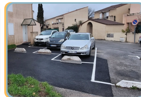
Remise en état des parkings - Les Cistes
