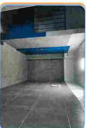
Remise en état des parties communes - La Savonnières
